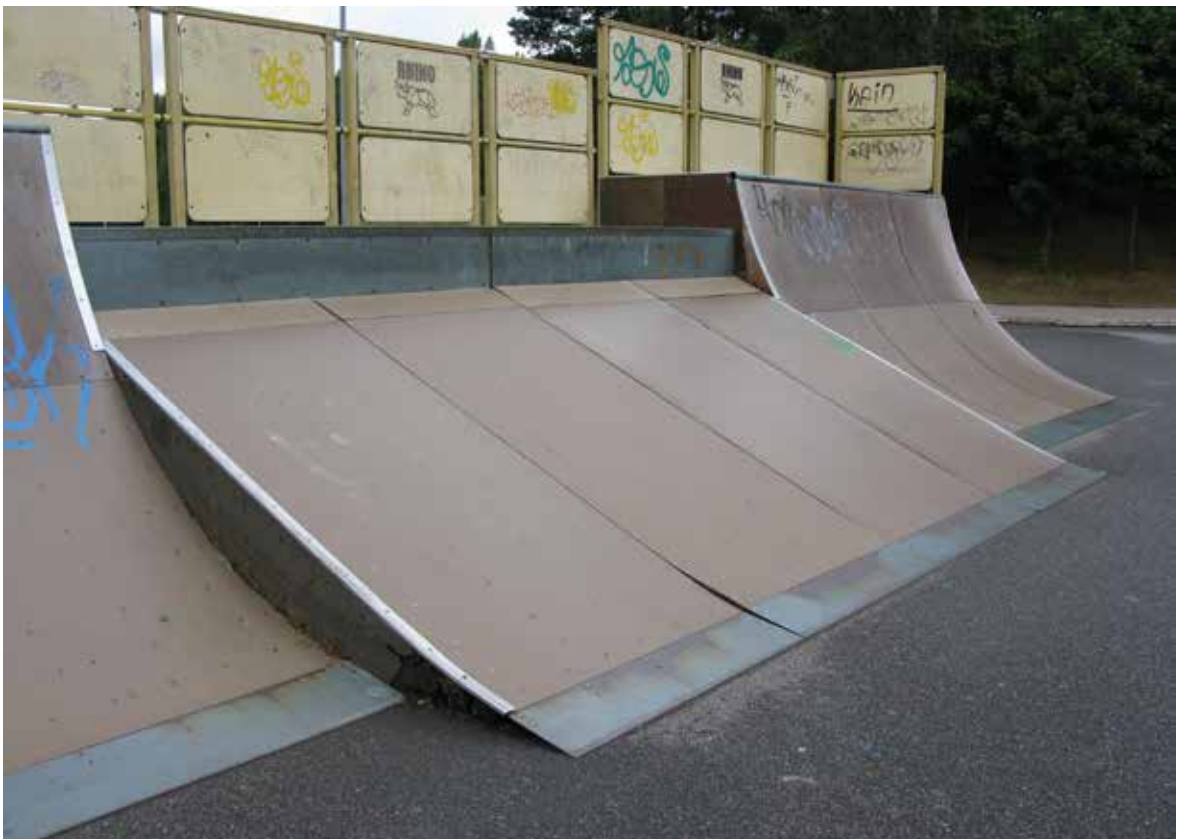
Alhaalla: Välineiden pintalevyjä on uusittu tarvittaessa, mutta myös niiden rungot ovat tulleet käyttökänsä päähän.
