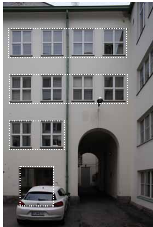
Sisäpihan julkisivukuvia vuodelta 2012. Ensimmäisen kerroksen ovet on vaihdettu ja ikkunajakoa on yksinkertaistettu. Julkisivun eteen on asennettu tekninen tila.
