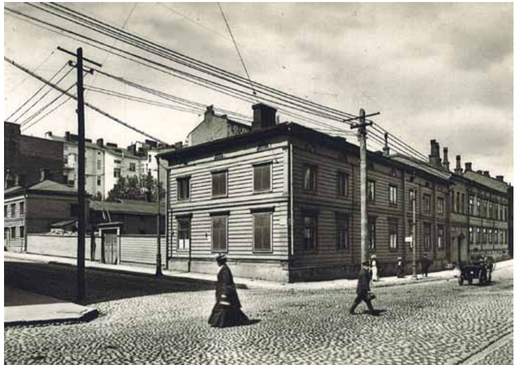
Vuoden 1908 valokuva Pienen Roobertinkadun ja Kasarmikadun kulmasta. Puurakennukset purettiin Kasarmintorin sähköaseman ja hallintorakennuksen alta. Helsingin kaupungin sähkölaitos 1909–1934, 36.
