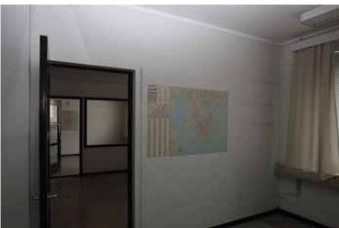
Huoneiden välisiä ikkunoita on levytetty.
