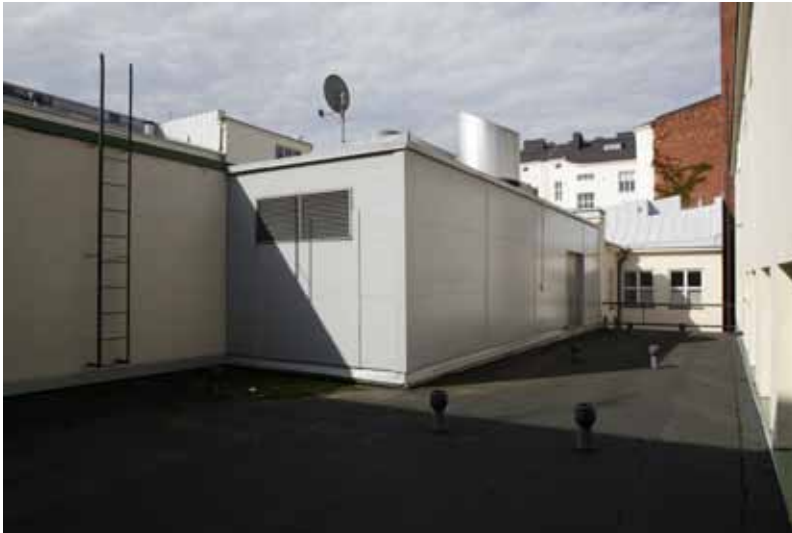
Iv-konehuone sähköaseman katolla. Tätä osaa korotettiin 1962.
