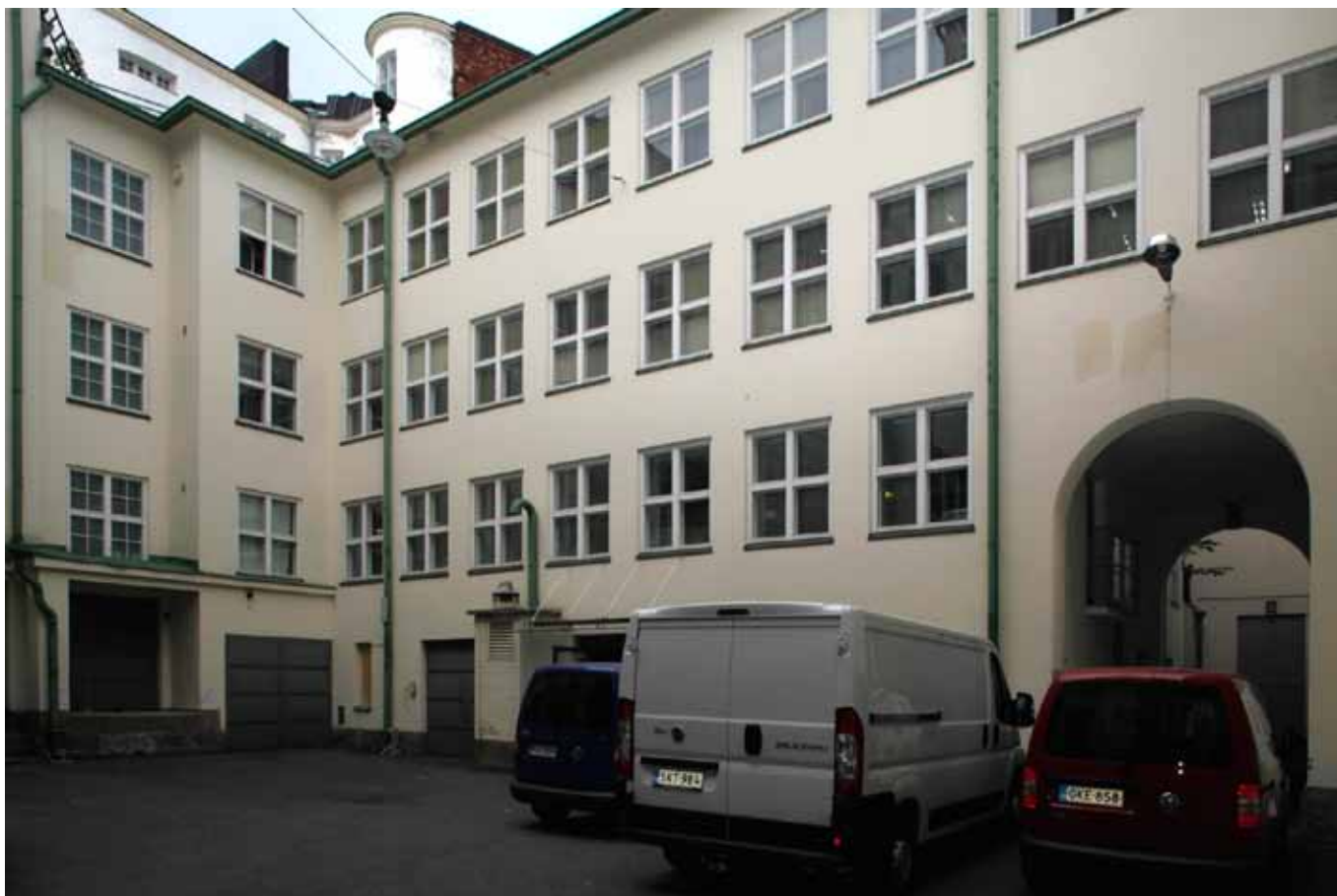
Nykytilavalokuvasta näkyy, että puitejakoa on yksinkertaistettu iikkunoiden vaihdon yhteydessä.
