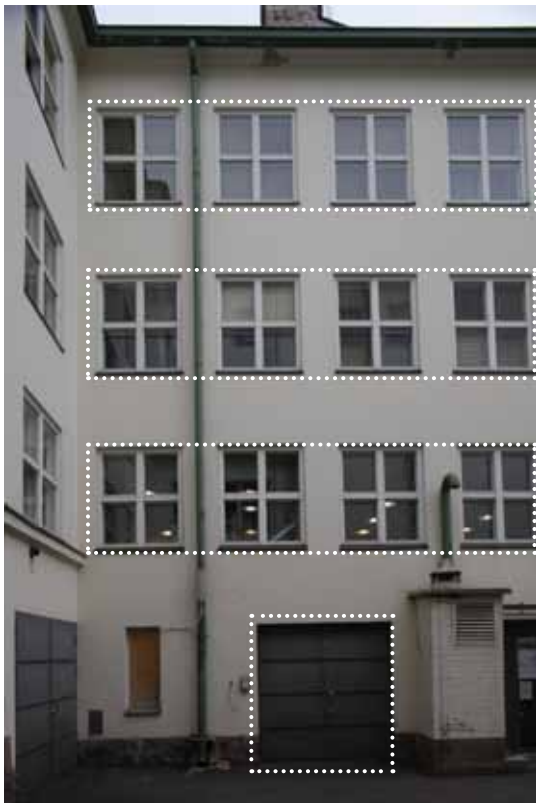
Sisäpihan julkisivukuvia vuodelta 2012. Ensimmäisen kerroksen ovet on vaihdettu ja ikkunajakoa on yksinkertaistettu. Julkisivun eteen on asennettu tekninen tila.
