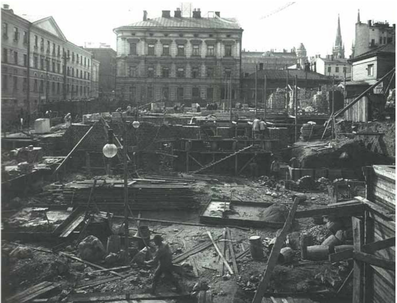
Pienen Roobertinkadun ja Kasarmikadun kulmatontin rakennustyömaa kesällä 1908. Turpeinen 1984, 65.
