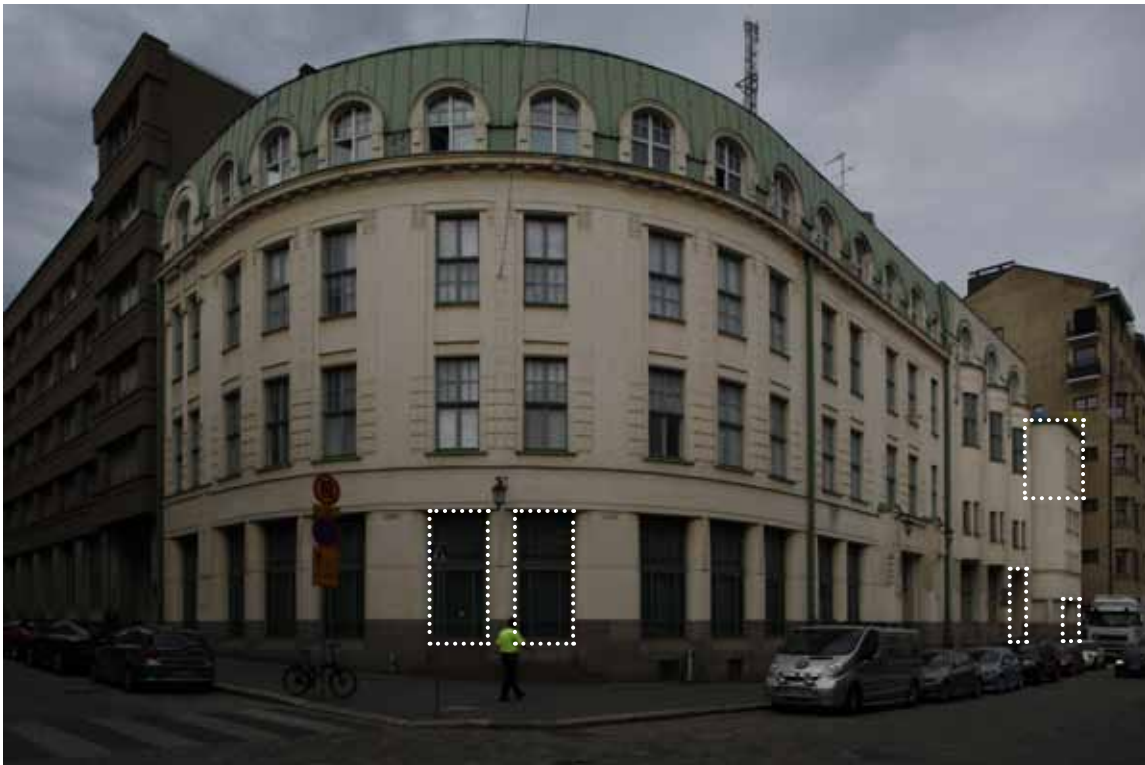
Valokuva nykytilanteesta vuodelta 2012. Vuoden 1909 jälkeiset muutokset on merkitty kuvaan. Kaaren kohdalla sijainnut porras ja sisäänkäynti poistettiin 1989.
