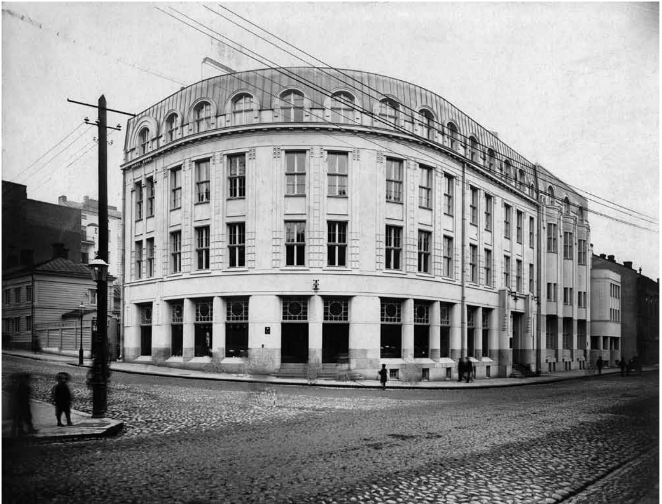
Kasarmintorin sähköasema ja hallintorakennus valmistumisensa jälkeen vuonna 1909. HKM KA.
