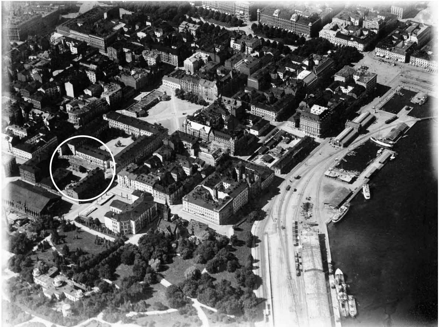
Kaartinkaupungin ilmakuva vuodelta 1924. Sähköasemarakennus sijaitsee Kasarmintorin lounaiskulmassa. Edessä vasemmalla näkyy Tähtitorninvuori, oikealla Eteläsatama. HKM KA.
