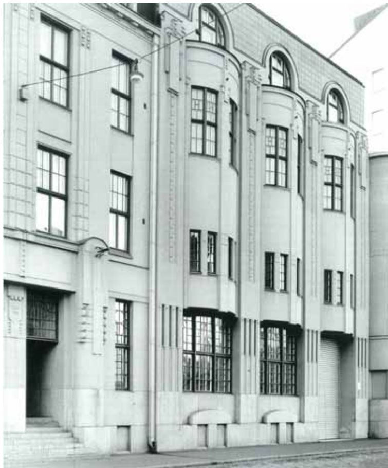
1908–1909 rakennetun sähköaseman julkisivua Kasarmikadulle päin.
