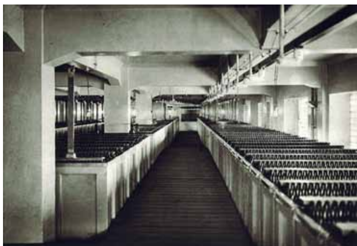
Kasarmitorin ala-aseman akkumulaattoriparisto kellarikerroksessa. Helsingin kaupungin sähkölaitos 1909–1934, 32.
