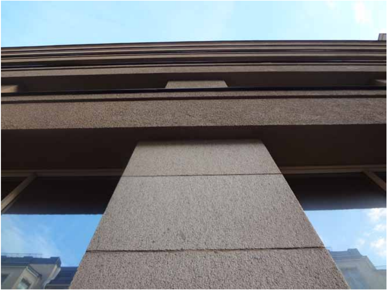
Pienen Roobertinkadun puoleista julkisivua vuonna 2012. Pilaririvi on sisennetty vaakasuuntaisesta vyöhykkeestä.
