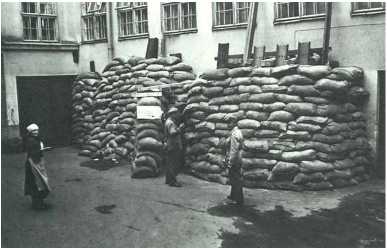
Kasarmintorin sähköaseman hiekkasäkkivarustusta sota-ajalta. Kuva Turpeinen 1984, 199.
