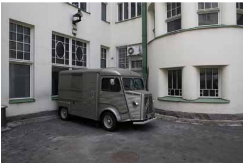
Sisäpihan kaakkoiskulkman julkisivua B-portaan kohdalta.
