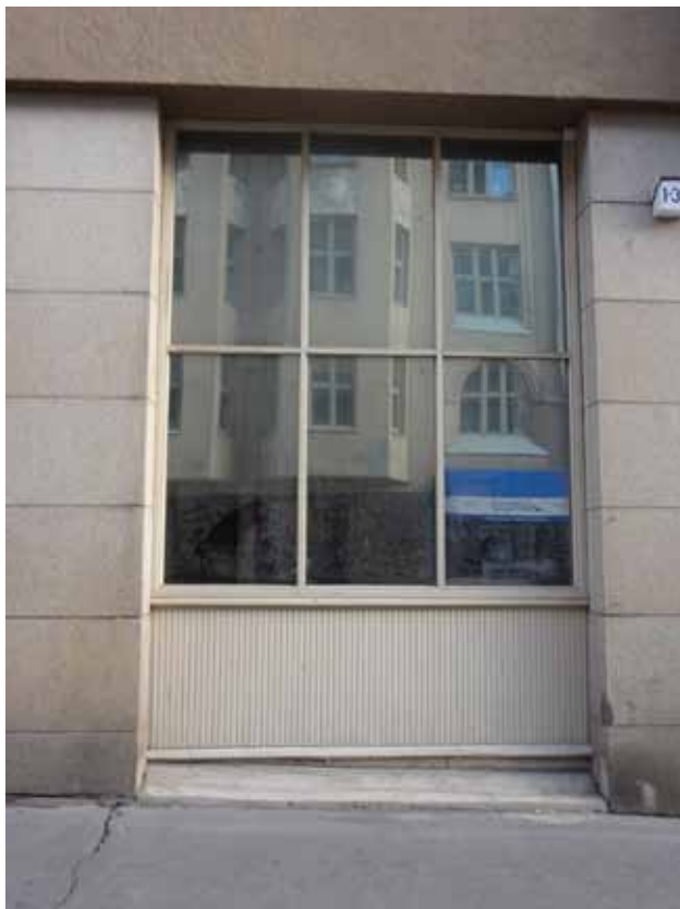
Katutason peili-ikkuna on uminainen. Ikkunan takana pukuhuone-tilat.
