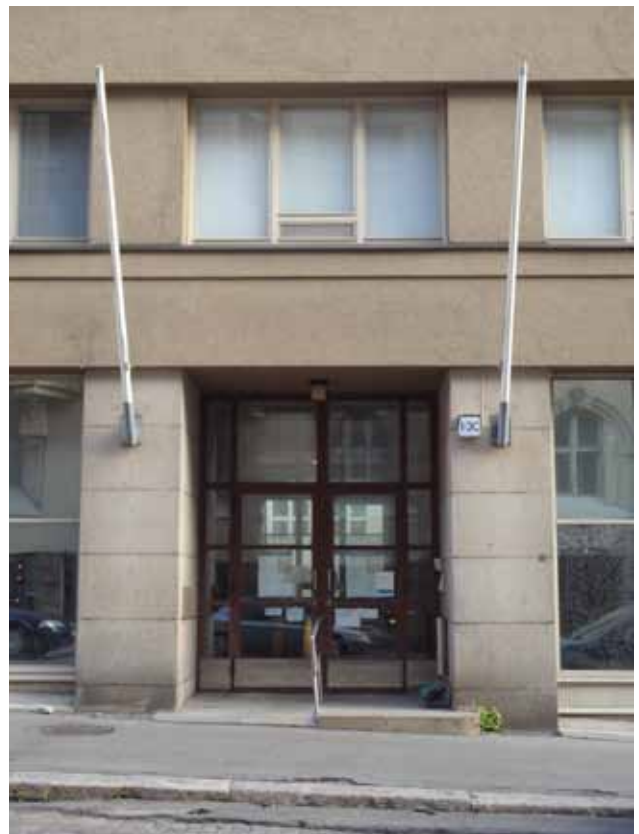
1931 valmistuneen osan pääsisäänkäynti vuonna 2012. Metalliovi on uudehko.
