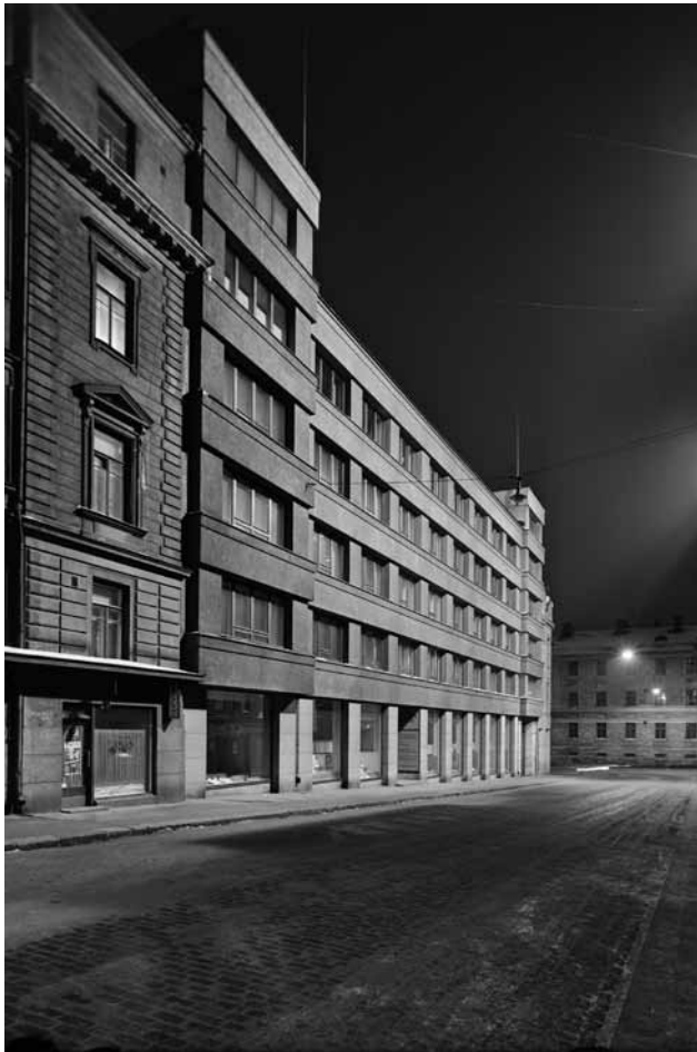
Pienen Roobertinkadun puoleinen teknillisten laitosten rakennus vuonna 1937. Kuva A. Pietinen Oy, HKM KA.
