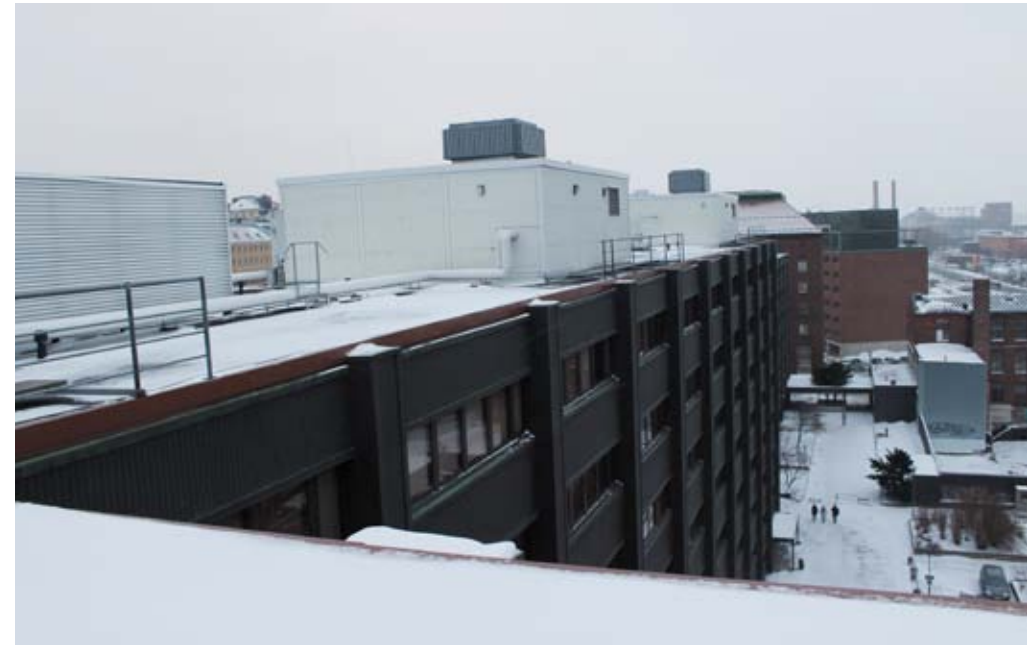
Konehuoneisiin on kulku katolta.
