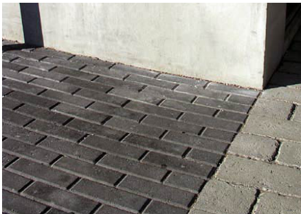
Pihan kiveykset ovat patinoitu betonikiveä harmaan eri sävyissä, vaihtelua saadaan erilaisilla ladonnoilla.
