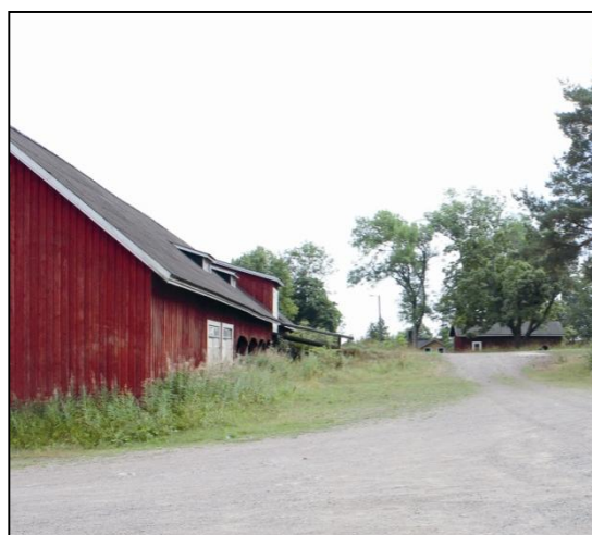
Vaunuvaja takaa. Näkymä Oy 2011.
