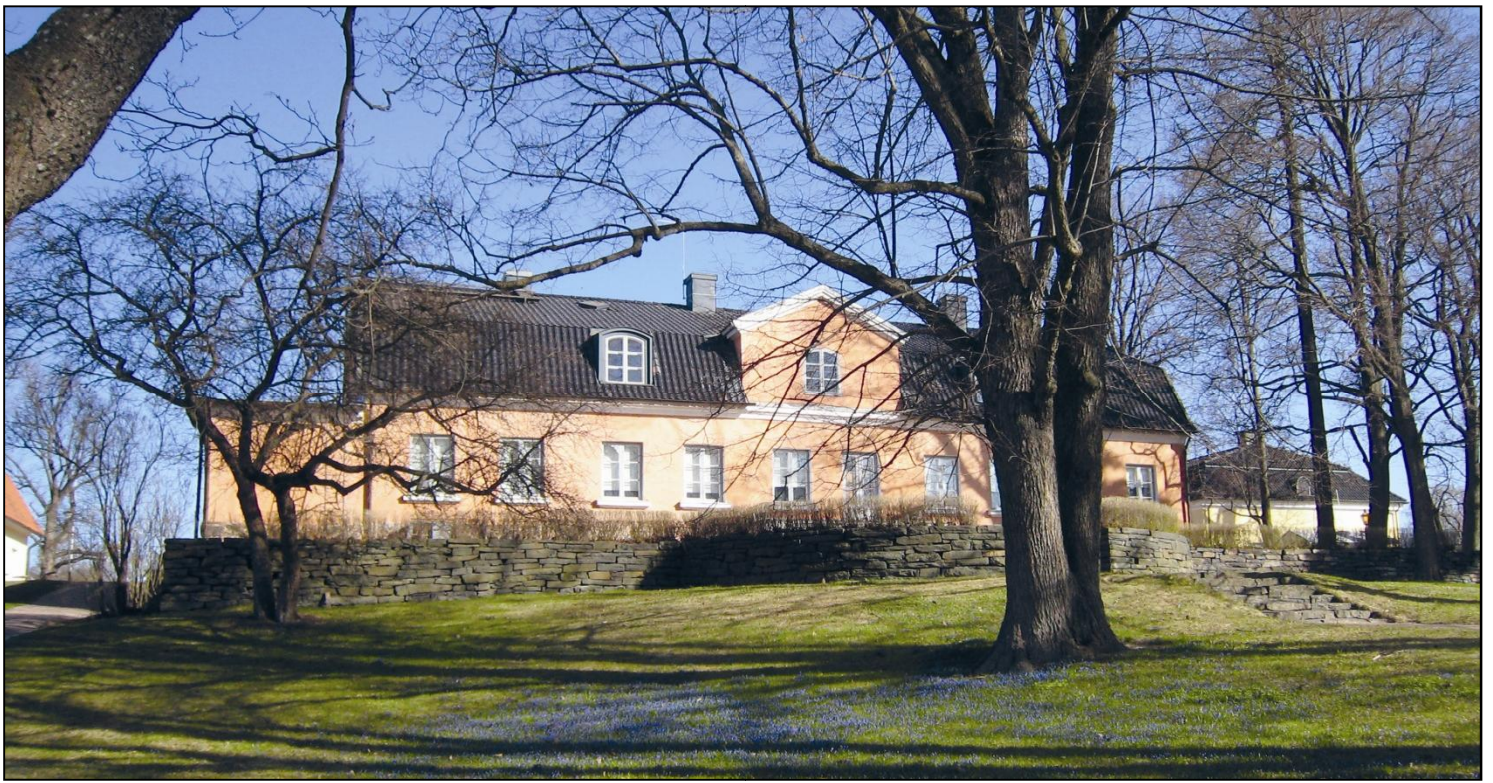
Kartanon eteläjulkisivu (nro 24).
