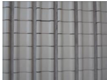
1990-luvun vaihteessa toteutetun laajennuksen, Elsan, julkisivussa on käytetty alkuperäisen kaltaisia keraamisia muotolaattoja.
