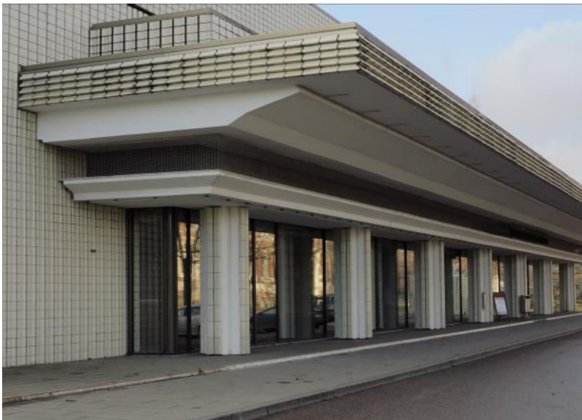
Elsan sisäänkäyntipylväikkö koilliseen v. 2012.
