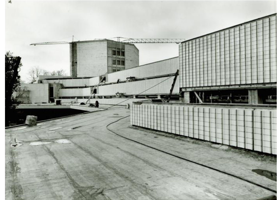
Rakennusvaihe. Kuva on otettu sisäänkäyntikatoksen päältä. Oikealla harjoitusalin yläikkunanauha. Valokuva Pietinen SRM Ulkopuolen verhouksena käytettiin Arabian valmistamia keraamisia laattoja, jotka muuraamalla kiinnitettiin aikaisemmin valettuihin betonielementteihin. Elementit kiinnitettiin ulkoseiniin hitsaten runkovaiheen aikana asennettuihin ruostumattomiin terästartuntoihin.
