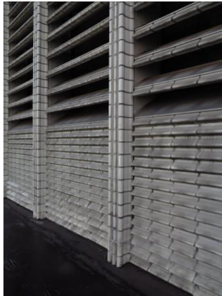
Näyttämötornin keraaminen säleikkö.
