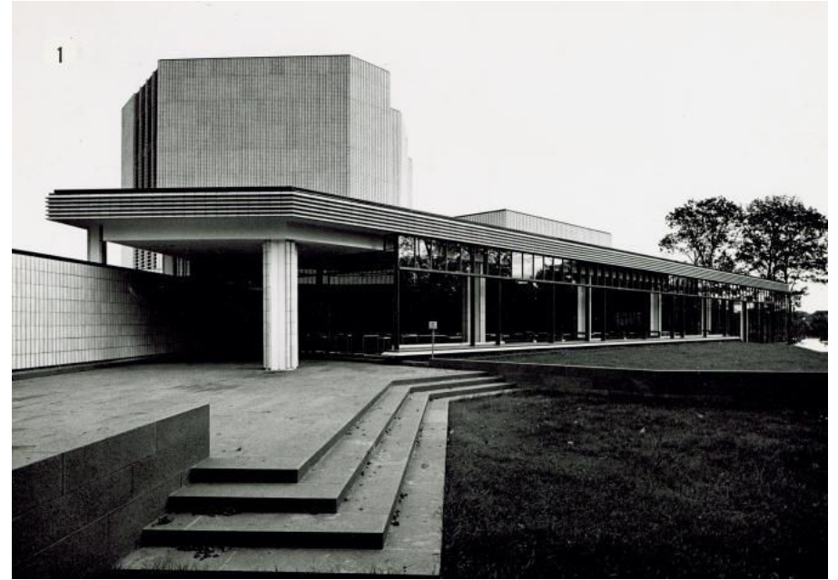
Lämpöön parveketason kahvion jatkeena on umpinaisen muurin suojaama kivetty terassi, jonka loivat maastoaskelmat liittävät puistonurmikkoon. Kuva 1960-luvulta. Martti I. Jaatinen. SRM
