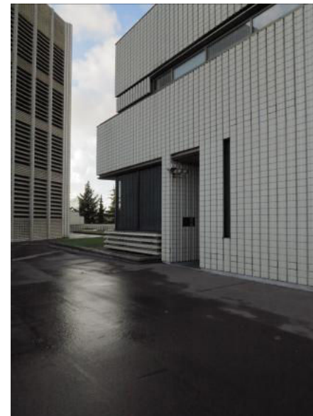
Elsan päätyjulkisivu kaakkoon 2012.
