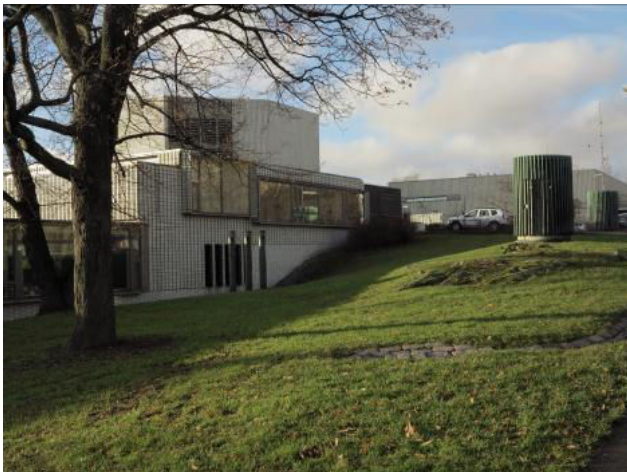
Tekniseen huoltoon liittyvät asennukset on sijoitettu rakennuksen luonteeltaan "arkisemmalle" koillisivulle.
