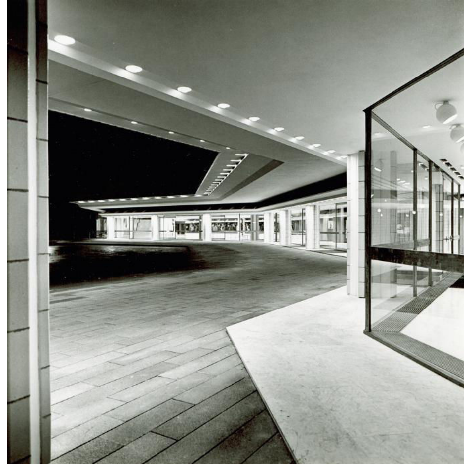
Sisäänkäynti lippukassalle ja lämpiöihin valaistun, ulkonevan lipan alta. Sisä- ja ulkotilojen välitön yhteys ja esimerkiksi samojen materiaalien käyttö sisä- ja ulkotilassa on teatterirakennukselle ominainen piirre, joka korostuu lämpiöseinän ohuiden lasirakenteiden avulla. Valokuva 1960-l. Martti I. Jaatinen. SRM
