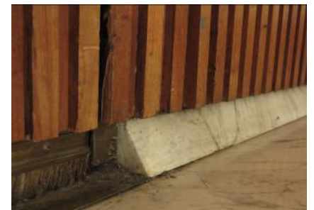
Sisäseinän vaimennusverhous ja marmorijalkalista.
