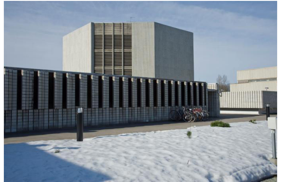
Pohjoissivu. Pienen näyttämön yläosan koillissivu. Julkisivua elävöittävät keraamisilla muotolaatoilla päällystetyt savunpoistoluukut. Kuvat 2012 Kari Hakli
