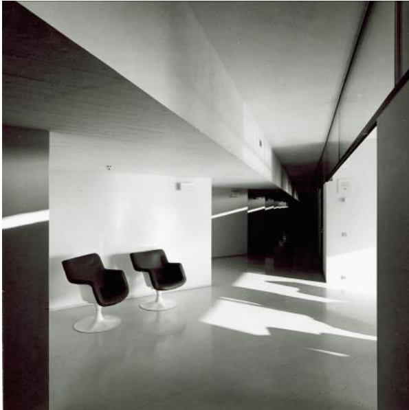
Teatterin henkilökunnan toimisto- ja pukutilojen käytävä. Alakatto on paikalla valettua, muottipintaista betonia, pintakäsittelyinä maalaus. Lattiapäällysteenä on valkea vinyylimatto. Sisäikkunoiden ja ovien karmit ovat mustaksi maalattua teräsprofiilia. Ovien värikoodaus vihreän, keltaisen ja punaisen avulla, punaisella nahkalla päällystetyt nojatuolit sekä tummansinisiksi maalatut kiintokalusteet luovat selkeän ominaisleiman. Kuva 1960-luvulta Martti I. Jaatinen. SRM
