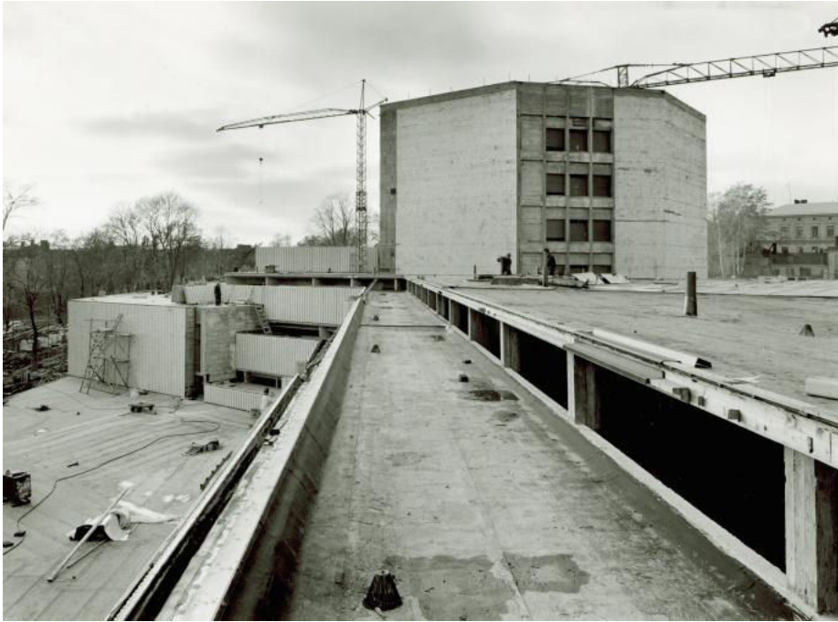
Rakennusvaihe. Oikealla 4. kerroksen yläikkunanauha. Valokuva Pietinen. SRM
