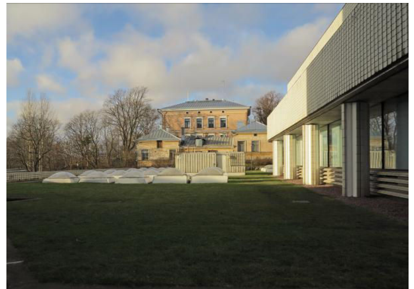
Studio Elsan lounaisjulkisivu ja 1. kerroksen työpajatilojen kattoikkunat.
