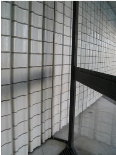
Muovilevy ulko- ja sisätilojen liitoskohdassa.
