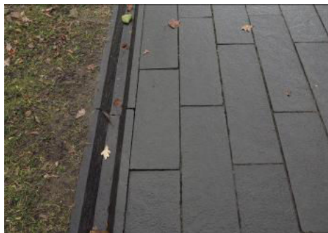
Luoteis-kaakkoissuuntainen, graniittilaatoilla laatoitettu ja vesikourulla varustettu käytävä on teatterin alkuperäisen pihalueen hyvin säilyneitä elementtejä.
