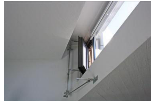
Pukuhuone 227, tuuletusikkuna avauslaitteineen.
