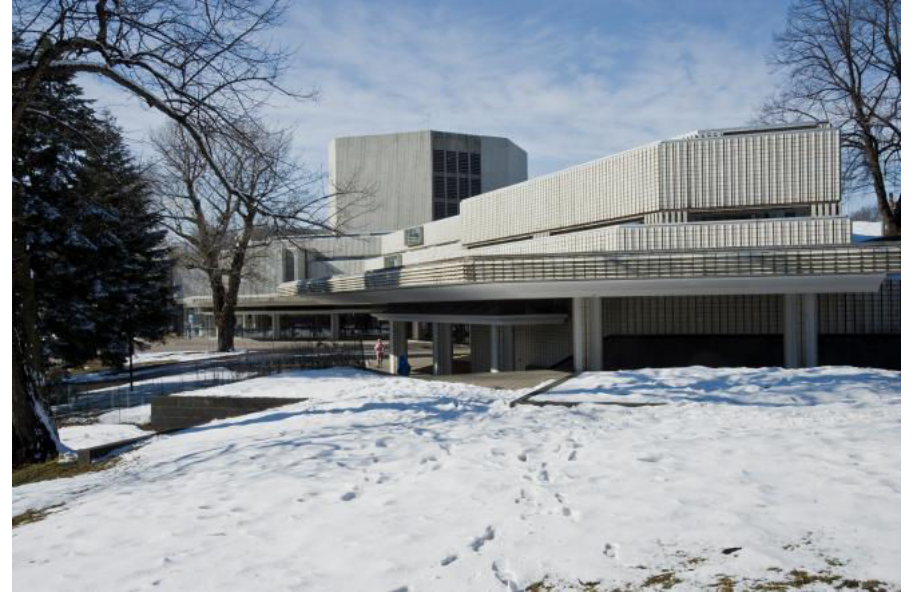
Julkisivu kaakkoon v. 2012. Kari Hakli
