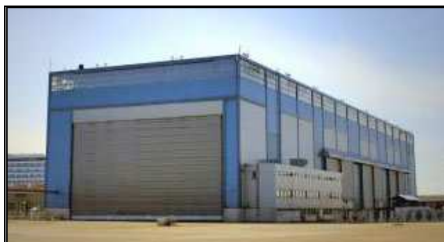
Kuva 3. Rakennus 83: Teräs/betoni-rakennus on valmistunut v. 1985
