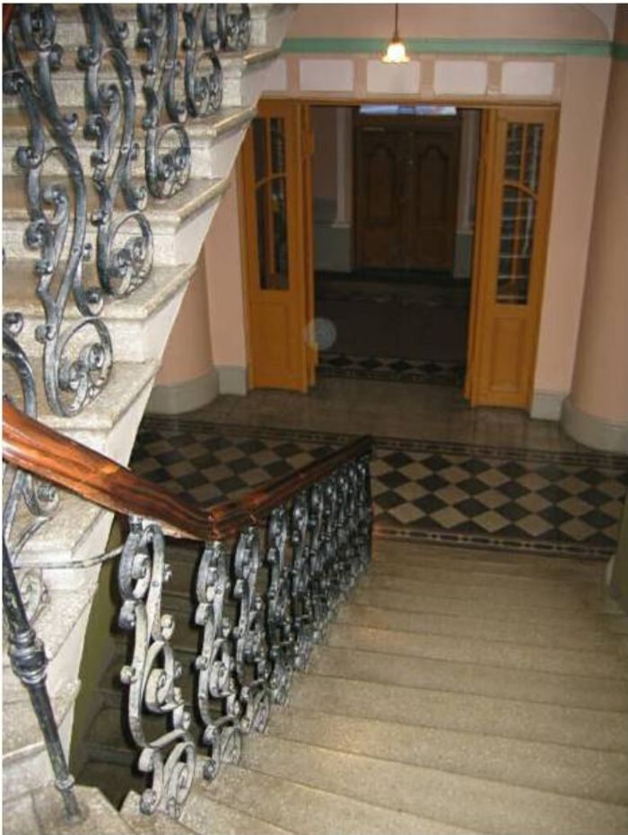
Porrashuone ennen hissien asentamista
