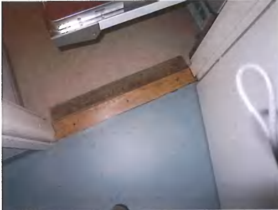
Siivouskomeron muovimatto on irronnut kynnykseltä ja sen liittyminen lattiakaivoon on puutteellinen
