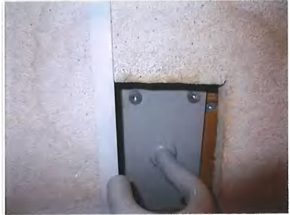
Päiväkoti Veijarin nukkumatilassa katossa akustolevyssä havaittiin valumajälkiä kattokoukun kohdalla
