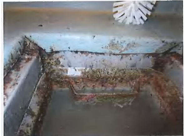
Siivouskomeron muovimatto on irronnut kynnykseltä ja sen liittyminen lattiakaivoon on puutteellinen
