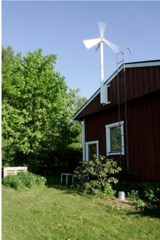
Kuva 18. Rakennuksen seinään asennettu pientuulivoimala (Janne Käpylehto / www.pienenergia.com ).
