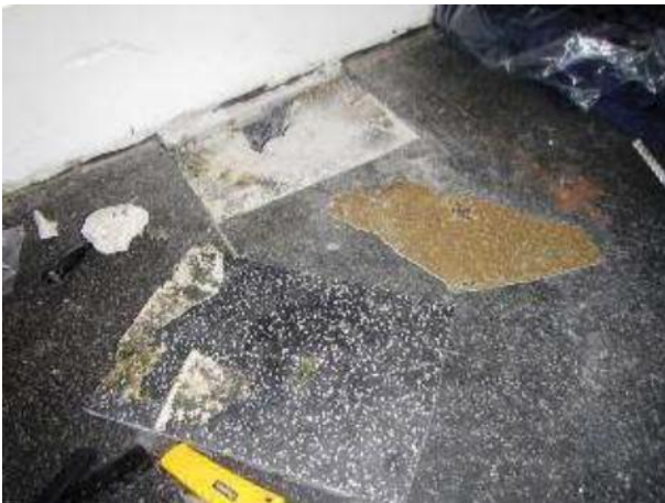
Kuva 3. Rakenneavaus AP1 putkikanavan vastaisen seinän viereltä
