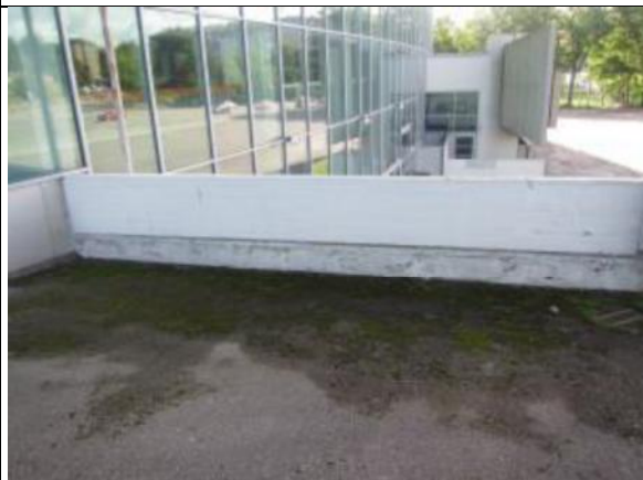
Kuva 10. Kaide-elementin pakkasrapauma ja terästen vauriota harjoitushallin toimisto-osassa.
