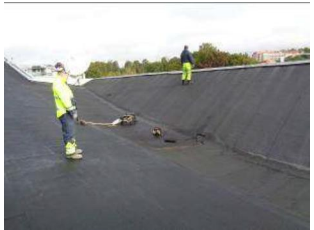
Kuva 83. Rakenneavaus tehtiin päätyrystään taitekohtaan.
