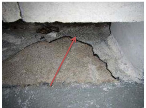
Kuva 23. Tiiliseinän ja betonin välissä bitumikermi
