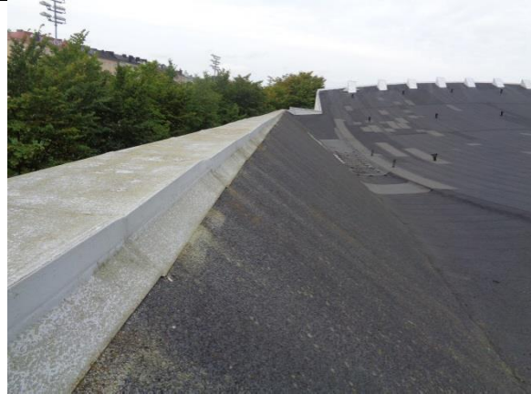
Kuva 55. Rästäiden pellitysten kaatosuunta on paikoin ulospäin
