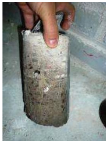
Kuva 10. Alapohjalaatta on märkä alareunasta noin 80 mm ylöspäin
