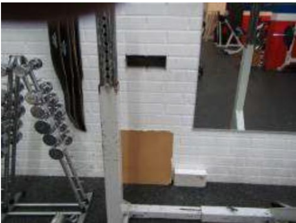
Kuva 73. Rakenneavaus VS1 kuntosalin puolelta
