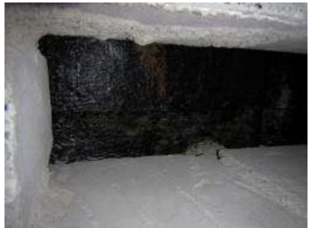
Kuva 74. Jäänhoitokonetilan puolella on betonin pinnassa pikisively kosteussulkuna
