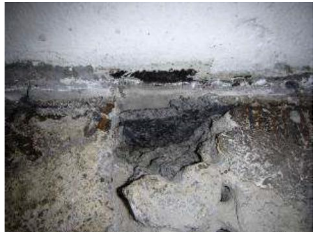
Kuva 4. Solumuovi irrotuskaistana seinän ja alapohjan liittymässä
