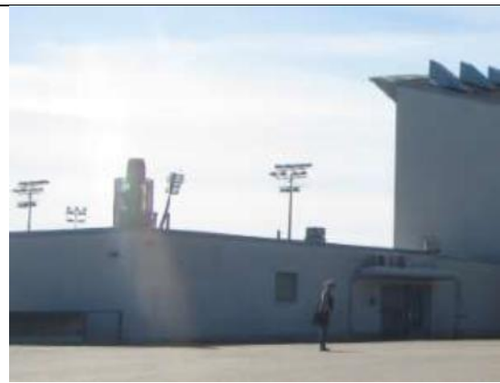
Kuva 14. Toimistolaajennus B:n julkisivua
