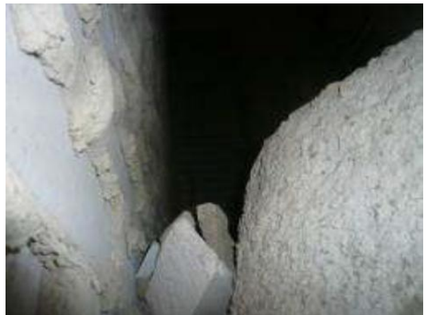
Kuva 76. Tiiliverhouksen takana on tiilmursketta ja saumauslaastia. Kuvassa kalliuseinäämä on ruiskubetonoitu
