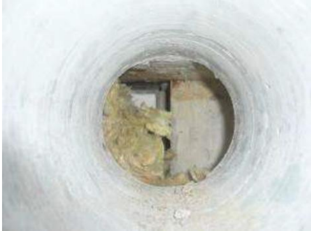
Kuva 50. Rakenneavaus US7, avauksessa betonipilarin ja sisäverhousmuurauksen liittymä
