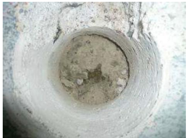
Kuva 19. Maaperä avauksen alapuolella kuivaa
