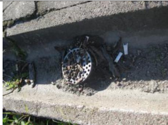
Kuva 4. Kourun sadeveden poisto.
