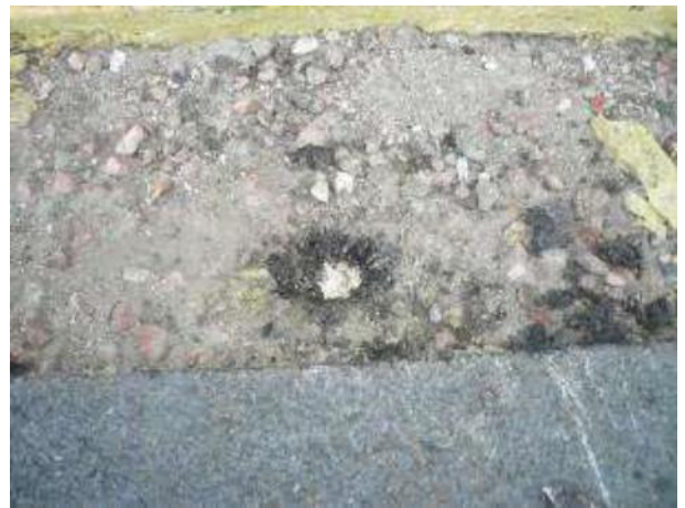
Kuva 91. Soraa pikimassan päällä
