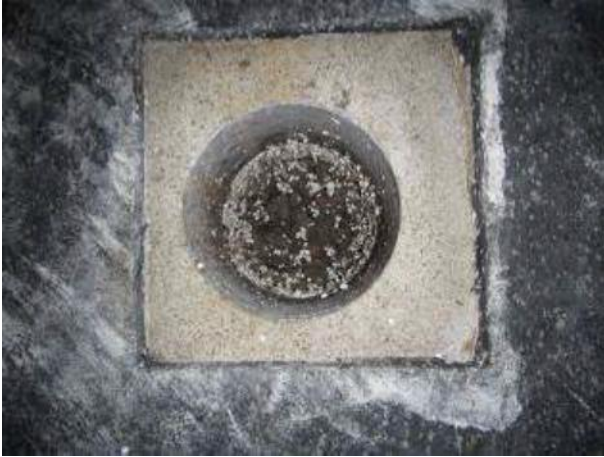
Kuva 1. Rakenneavaus AP1 huonetilan keskialueelle
