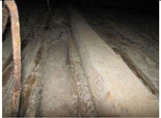
Kuva 29. Tiiliverhouksen ja betonirakenteen välissä puukoolaus
