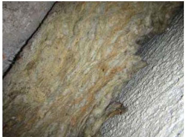
Kuva 60. Ulkoseinän rakennetta avauskohdan yläpuolella
