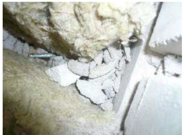
Kuva 56. Laastipursetta eristetilassa
