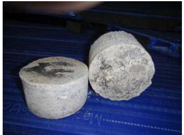
Kuva 21. Betonikerrosten välinen pikisively
