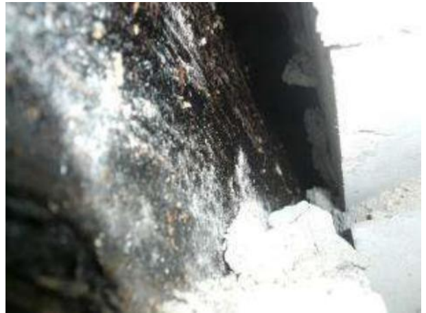
Kuva 25. Ilmavälin alaosa on laastipurseiden tukkima
