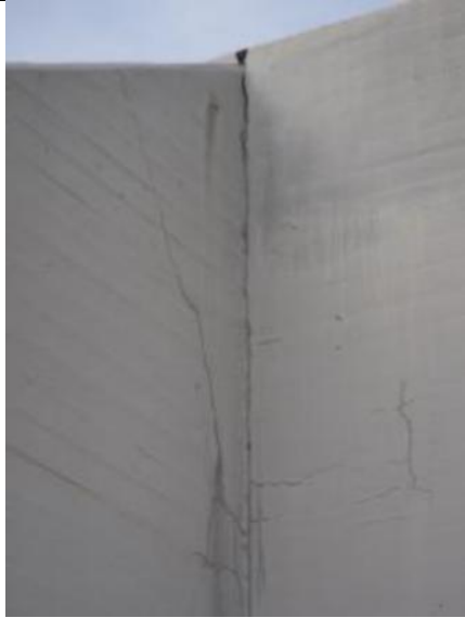
Kuva 7. Harjoitushallin toimisto-osan portaikon kaideelementit ovat rapautuneet
