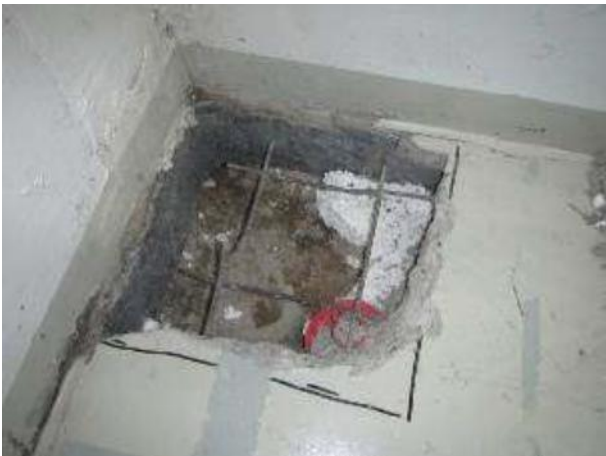
Kuva 5. Rakenneavaus AP2
