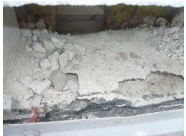
Kuva 62. Ensimmäisen tiilikierroksen alla on kapillaarikatkona bitumihuopa
