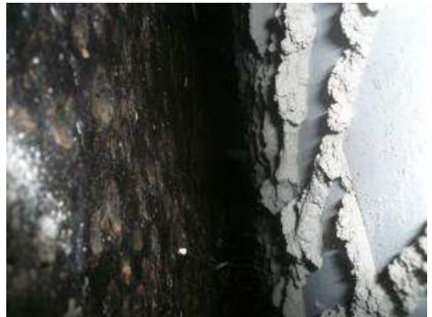
Kuva 37. Verhomuurauksen ja betoniseinän välinen tila
