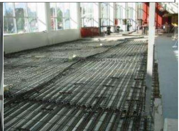
Kuva 26. E-tason liittolaattavälipohja, kuva Jääkenttäsäätiön arkistosta
