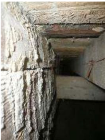
Kuva 17. Laatan alapuolinen tyhjä tila
