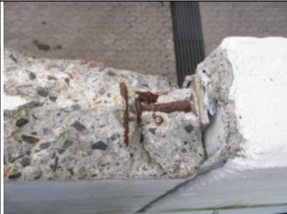
Kuva 10. Kaide-elementin pakkasrapauma ja terästen vauriota harjoitushallin toimisto-osassa.
