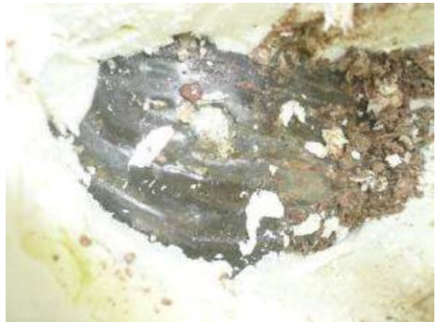
Kuva 93. Avauksessa näkyy vedeneriste muovikalvon alta
