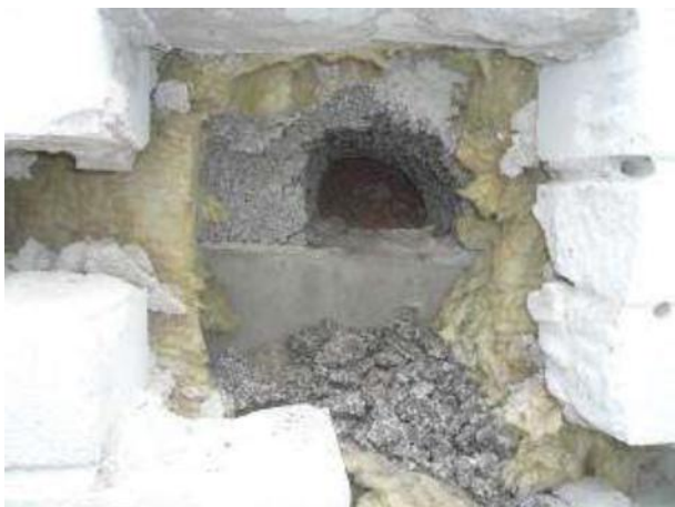
Kuva 40. Rakenneavaus US1, avauskohdassa pystyrungon ja kantavan yläpohjarakenteen liittymä
