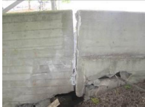
Kuva 2. Vaurion alapuolella täyttömaa valuu pois rakenteen vierestä.
