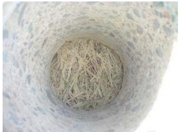
Kuva 44. Lastuvillalevy eristetilassa
