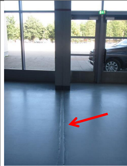
Kuva 24. Vanhan jäähallin liikuntasauama.
