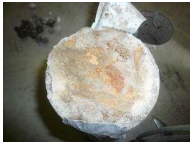
Kuva 72. Pintabetonilaatan alapinnassa on valupaperi
