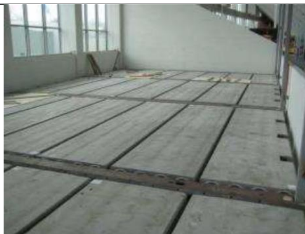
Kuva 25. Ravintolan uusi välipohja, deltapalkit ja ontelolaatat. kuva Jääkenttäsäätiön arkistosta
