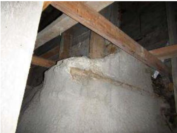
Kuva 33. Ontelotila on avonainen sulkulaattaan saakka
