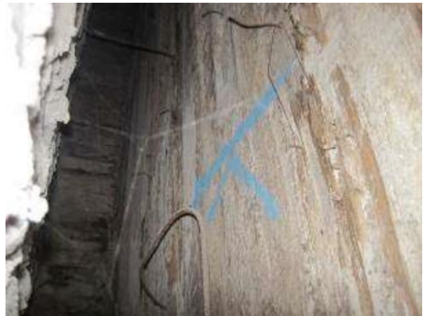
Kuva 31. Vanhaa muottilautaa
