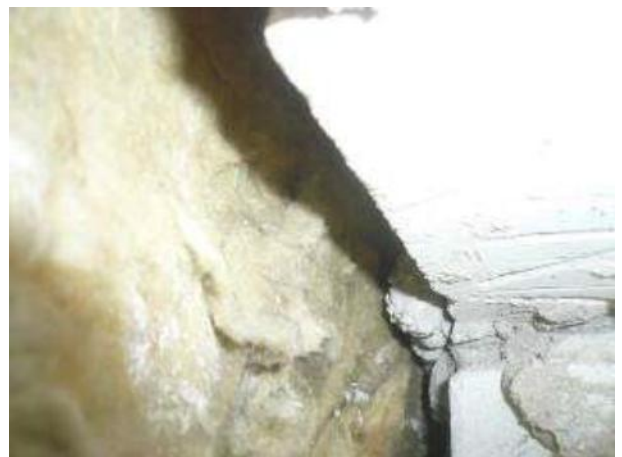
Kuva 41. Ilmavälissä on laastipurseita, jotka tukkivat ilmavälin
