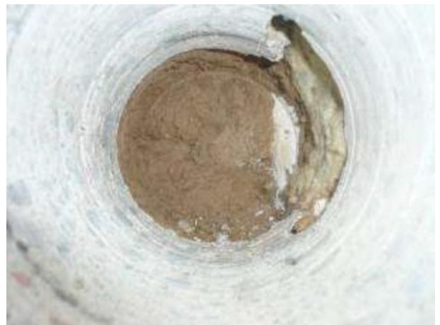
Kuva 49. Betoniseinän paksuus vaihtelee ja eristetilassa on sekä mineraalivillaa että huokoista puukuitulevyä
