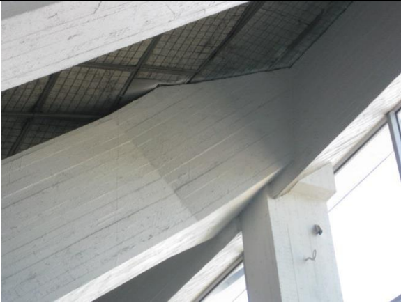
Kuva 60. Vanhan jäähallin runkorakenteet ovat hyväkuntoiset.
