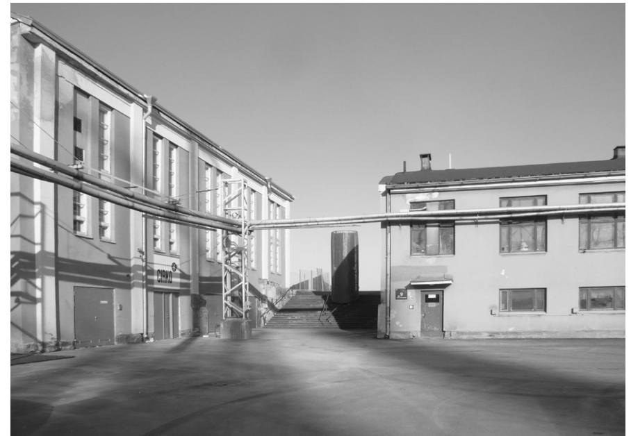
Kojuhuone, CIRKOn ilmanottotorni sekä mittarikorjaamo 2011. Valokuva S. Freese Vasemmalla: Sähkövoimalaitos 1983. HKM.
