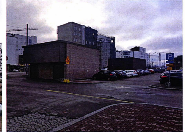
VALOKUVA MESSITYÖNKUJALTA ETELÄÄN Etualalla kalliopysäköinnin porraskuilu.
